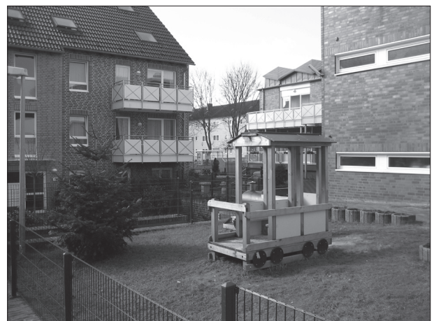
Abb. 3: Innenhof des Projekts „Wohnen auf dem Hangenberg“ [Quelle: M. Fedrowitz]
